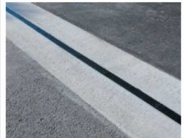
荷重分散型橋梁用伸縮装置(ジョイント和)の遊間部分に設置したSMジョイント
