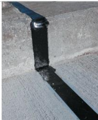
劣化したゴムが路面に露出することで、走行車両が損傷したり、二輪車転倒事故を引き起こす危険性がある
