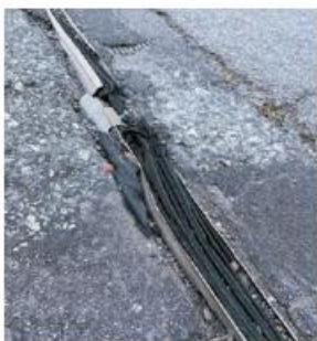
劣化したゴムが路面に露出することで、走行車両が損傷したり、二輪車転倒事故を引き起こす危険性がある
