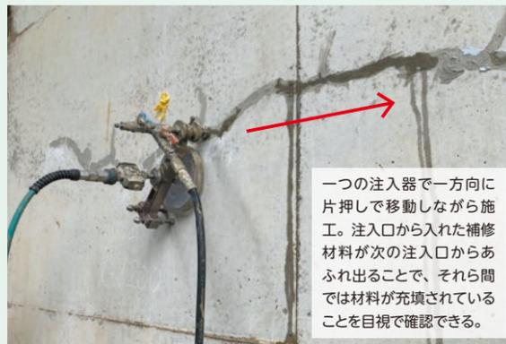
一つの注入器で一方に片押しで移動しながら施工。注入口から入れた補修材料が次の注入口からあふれ出ること、それら間では材料が充填されていることを目視で確認できる。
