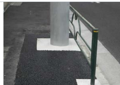
水道管工事後の再舗装（本復旧）に「ゴールドパッチ」を使用した。プラント加熱合材を使用する既往のアスファルト舗装と比較しても遜色のない仕上がりとなっている
