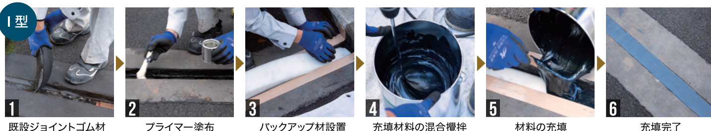
1 既設ジョイントゴム材 撤去
